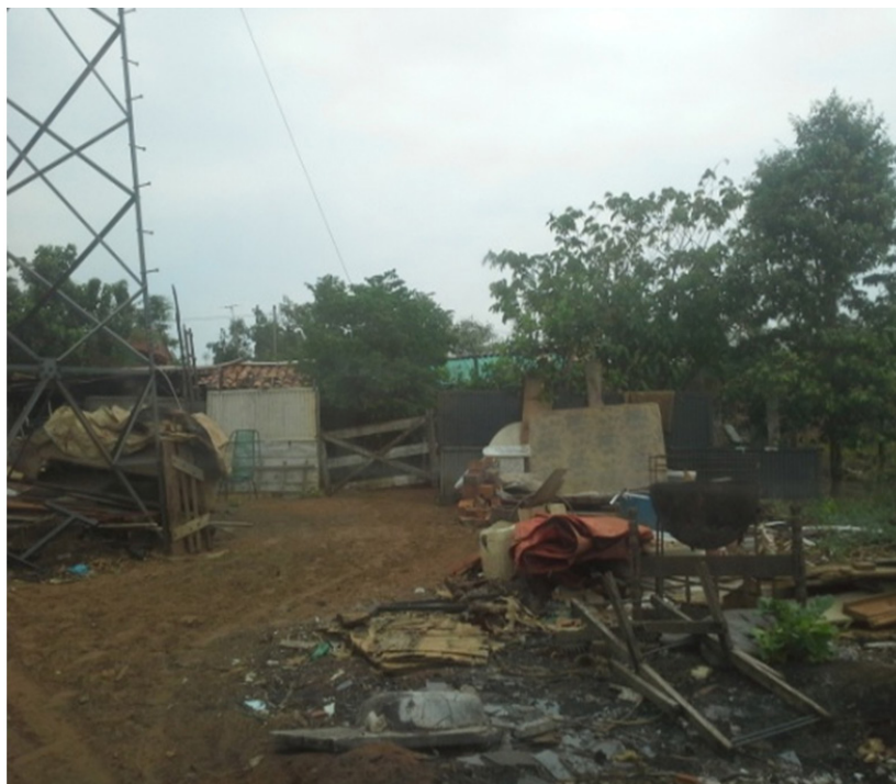
Figura 4 - Casa edificada sob rede de alta tensão
