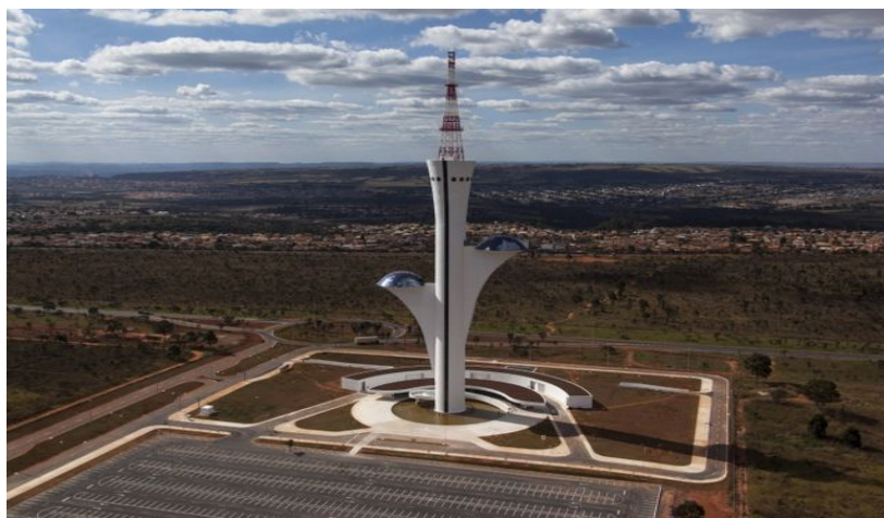
Figura 1: Torre de TV Digital de Brasília
