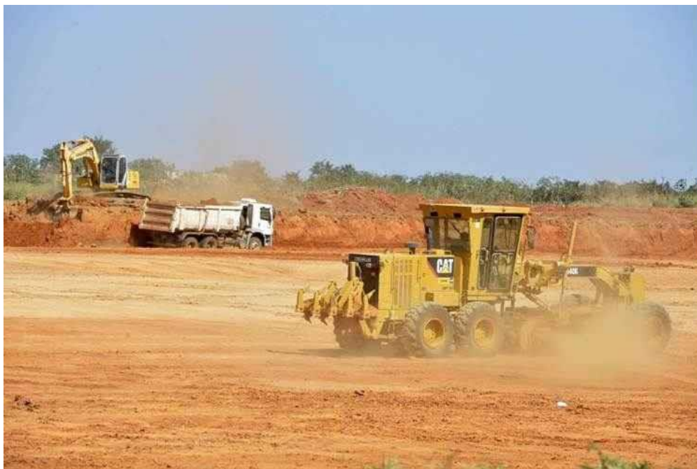
Figura 8: Aterro Sanitário Oeste em construção. ECO Brasília - http://www.ecobrasilia.com.br/2015/10/13/fim-do-lixao-primeira-unidade-do-aterro-oeste-esta-60-concluida/ , acesso em 30 de agosto de 2016.
