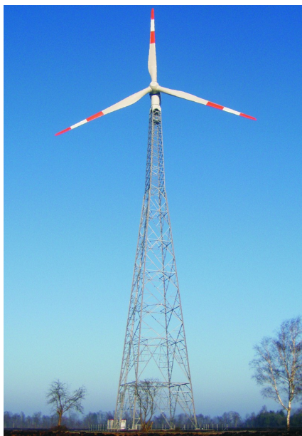
Figura 1.4: Torre eólica com aerogerador de eixo horizontal com torre treliçada. FONTE: http://www.brametal.com.br/produto/3/
