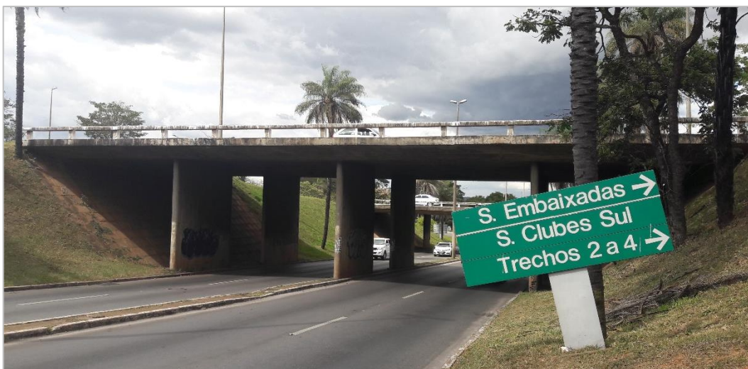
Figura 21 - Vista lateral da OAE 13.
