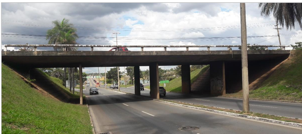
Figura 17 - Vista lateral da OAE, localizada na Avenida das Nações.
