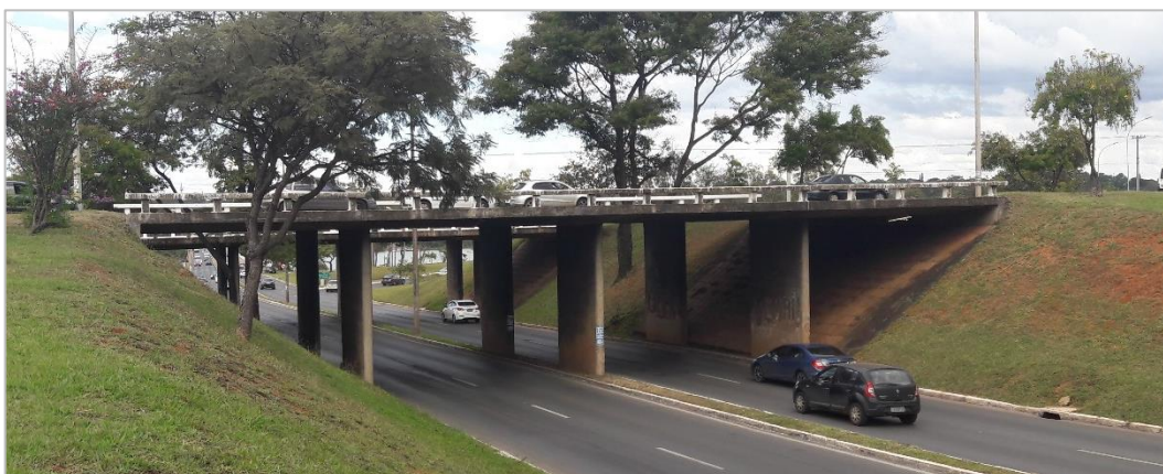
Figura 13 – Vista lateral da OAE 11, localizada na Avenida das Nações.
