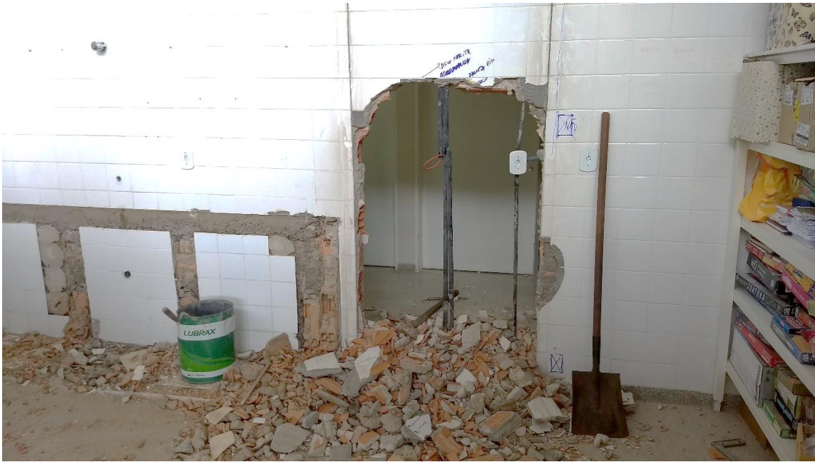
Figura 15. Abertura de vão para porta
