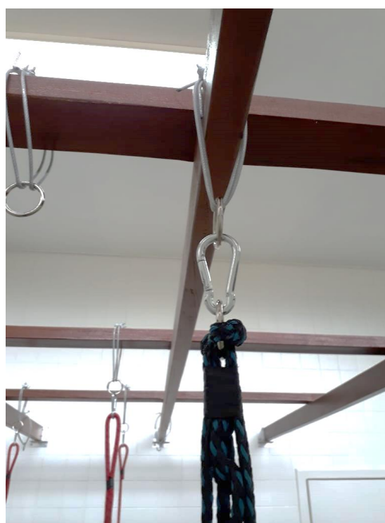
Figura 26. Detalhe da amarração das cordas
