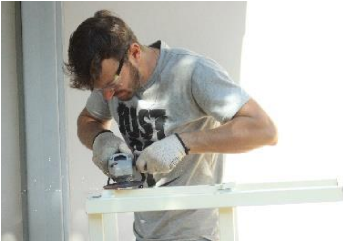
Figura 23. Execução das prateleiras
