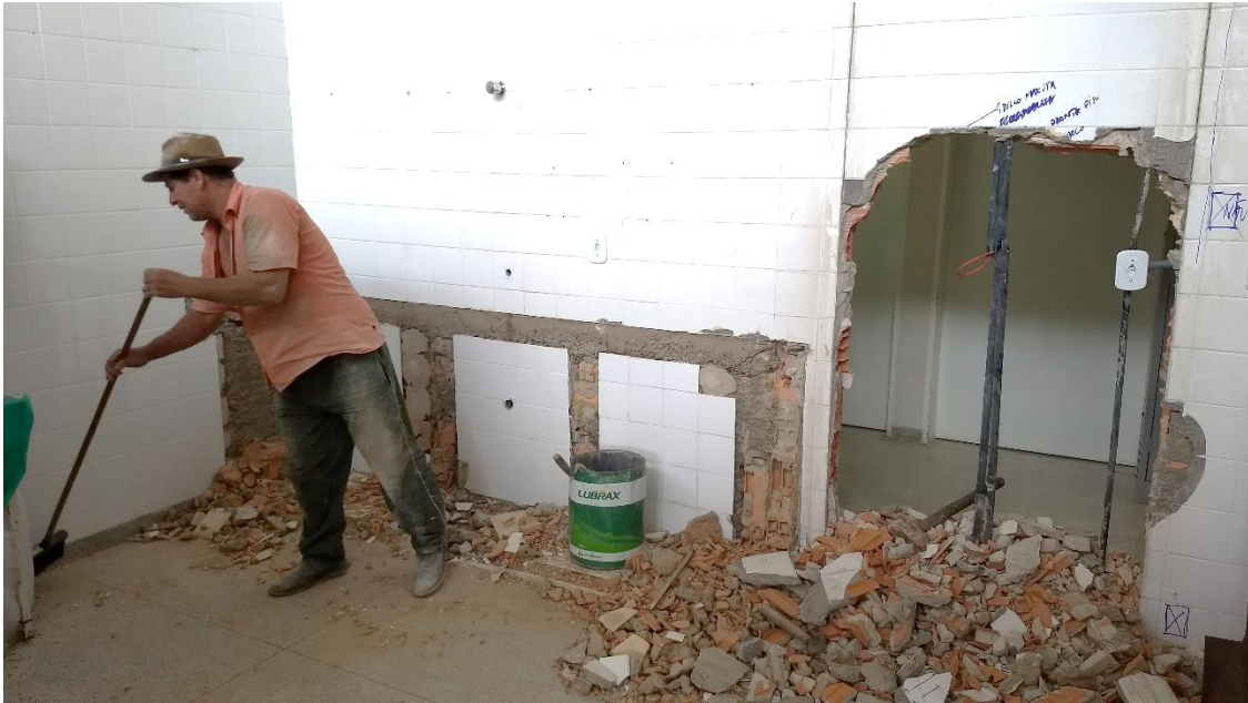
Figura 18. Abertura de vão para porta
