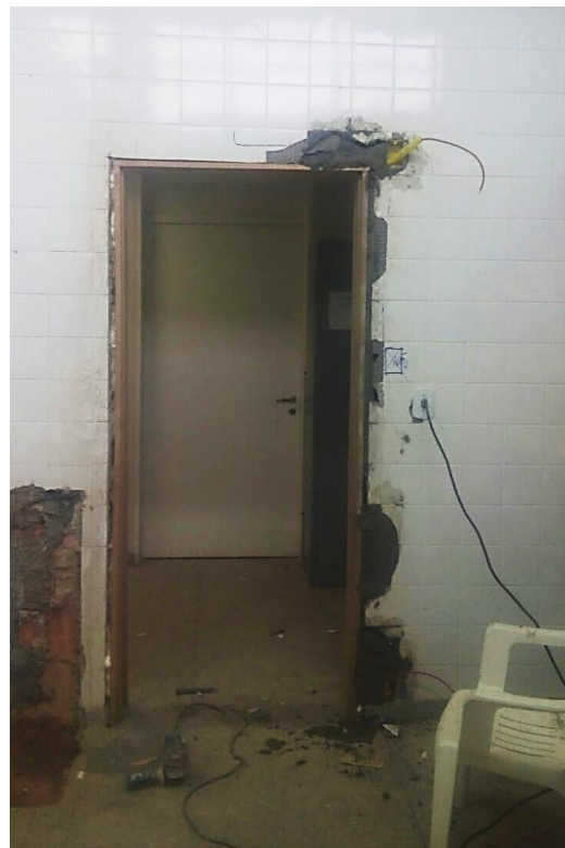
Figura 17. Instalação da nova porta
