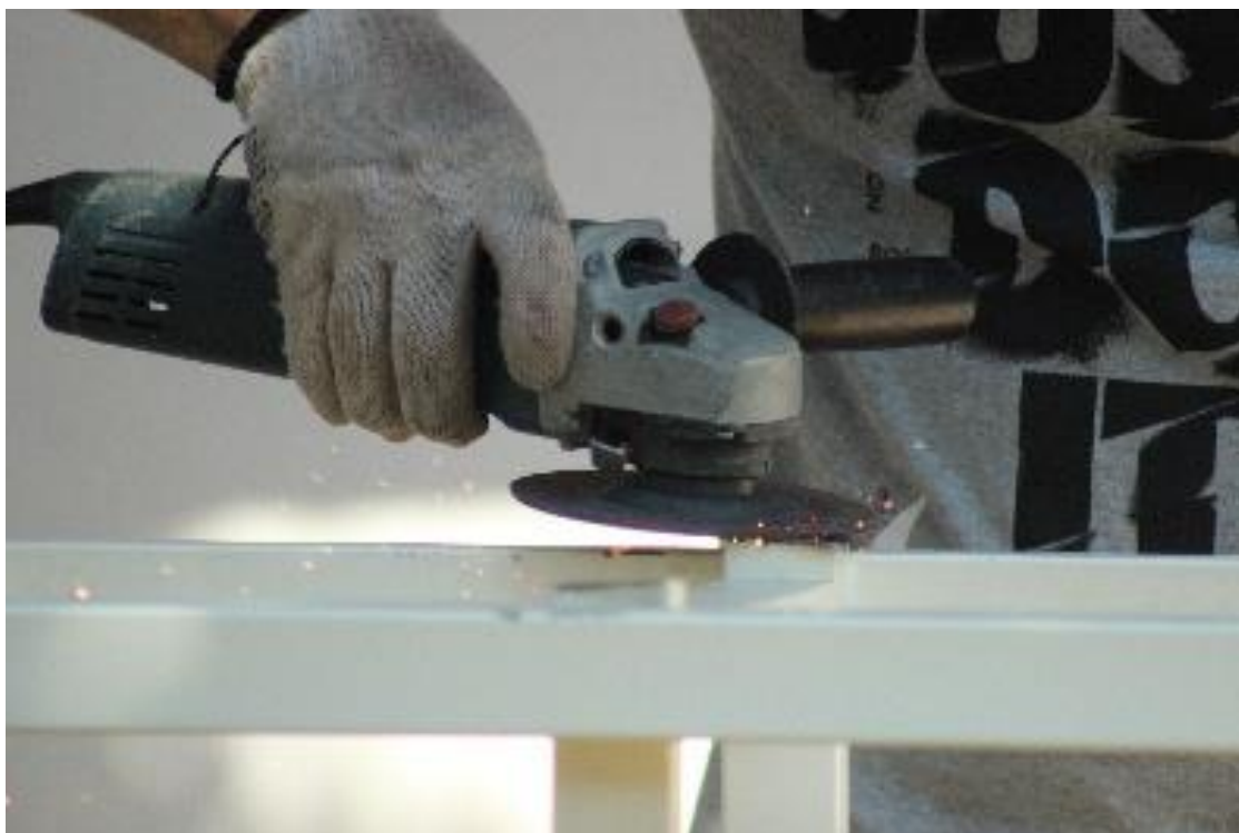
Figura 24. Execução das prateleiras
