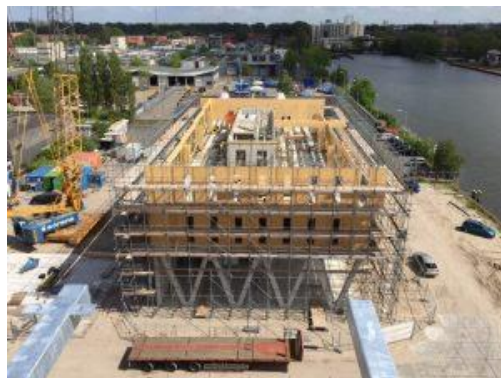
Figura 14: Estrutura do edifício Patch 22
