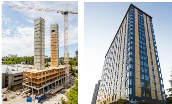
Figura 15: Construção do edifício Brock Commons
