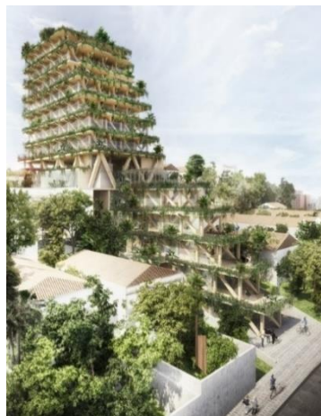
Figura 17: Amata – Edifício escalonado em CLT.
