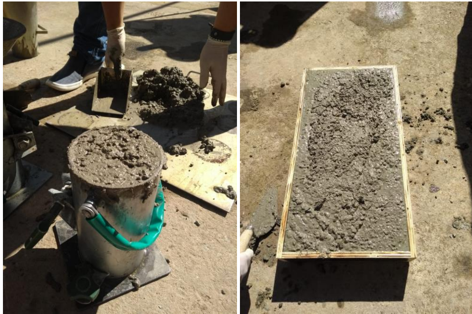
Figura 17- Concretagem dos corpos de prova e dos blocos
