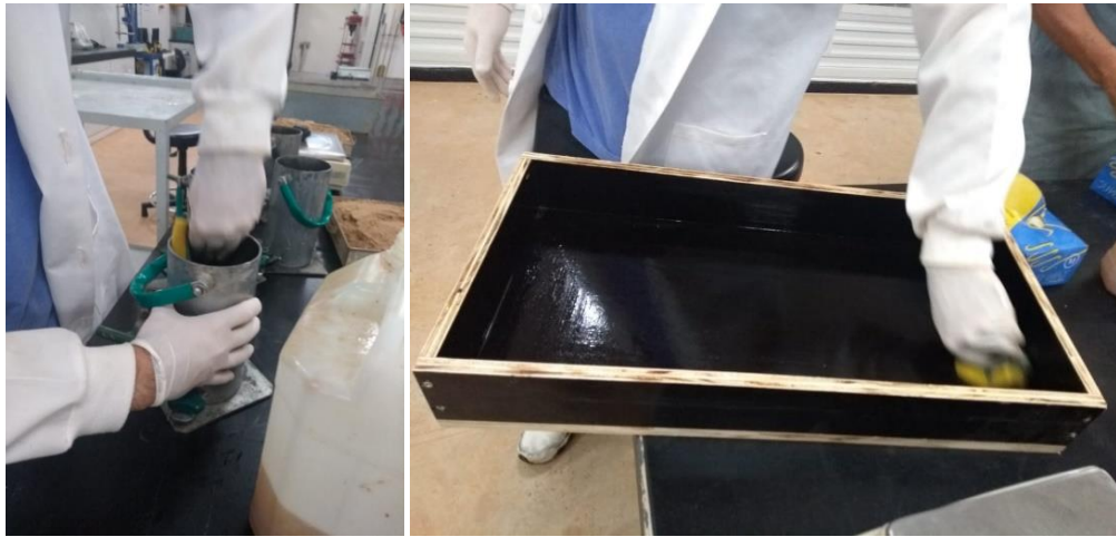
Figura 13 - Preparação das fôrmas utilizadas para a concretagem com a aplicação de óleo
