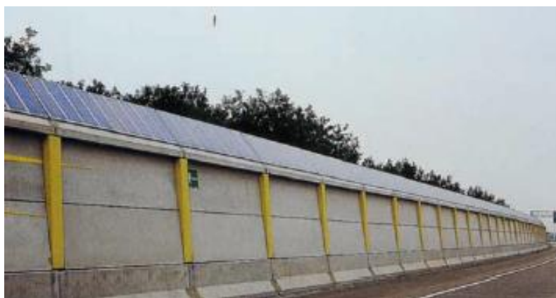
Figura 10 - Barreiras com painéis solares (Fonte: livro Environmental Noise Barriers , 1999)
