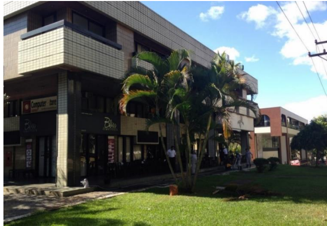
Figura 20 – Fachada posterior de bloco comercial da Asa Norte. Fonte: Fernanda Angelis. (2019).
