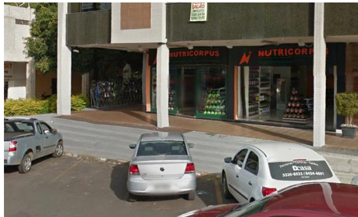
Figura 22 - Escadaria no local do passeio ao nível do solo, interrompendo o trânsito de pedestres. Fonte: Google Earth. (2019).
