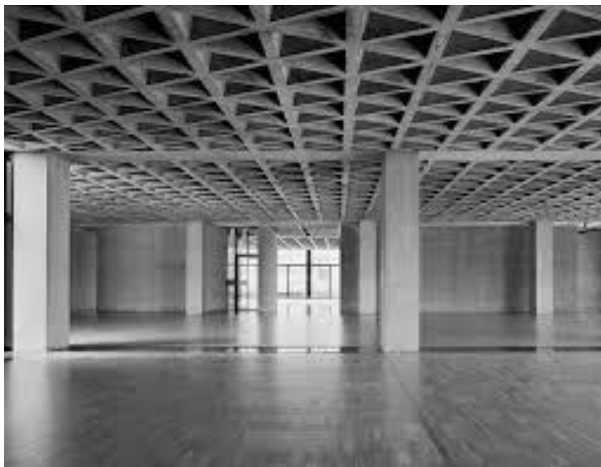
Figura 7 – Fotografia do pavimento superior da Galeria de Arte de Yale, evidenciando-se a relação do arranjo servente/servido e a modulação estrutural. Fonte: Louis I. Kahn Collection( https://www.philadelphiabuildings.org/pab/app/co_display_images.cfm/480049?IMAGE_GALLERY_SORTBY=StartYear&IMAGE_GALLERY_PAGE=18/ , acesso em 15/08/2019)
