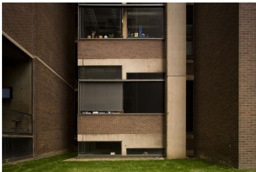
Figura 26 – Detalhe dos encontros e materiais utilizados na composição da fachada do edifício Richards. Fonte: Richard Anderson
