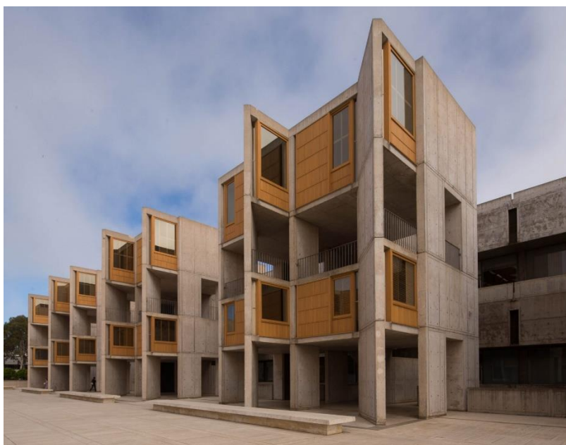
Figura 12 – Fotografia do Instituto Salk desde o pátio. No primeiro plano, temos as torres servidas de estúdios e atrás o grande bloco longitudinal de laboratórios. Fonte: Eleanor Gibson ( https://www.dezeen.com/2017/07/06/salk-institute-restoration-biological-studies-louis-khan-restoration-wje-getty-conservation-institute/ ) acesso em 16/08/2019
