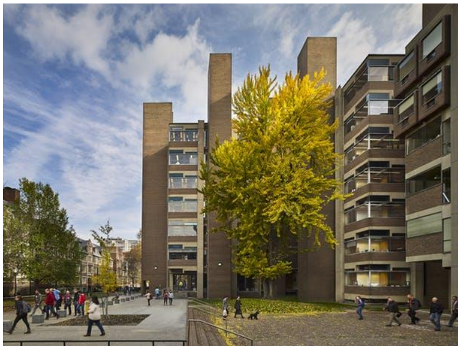
Figura 10 – Fotografia do edifício de laboratórios Richards. Percebe-se, na imagem, as preponderantes torres serventes que “nutrem” as torres de laboratórios. Fonte: Archinect ( https://archinect.com/aosarchitects/project/richards-medical-research-laboratory-renovations , acesso em 15/08/2019)
