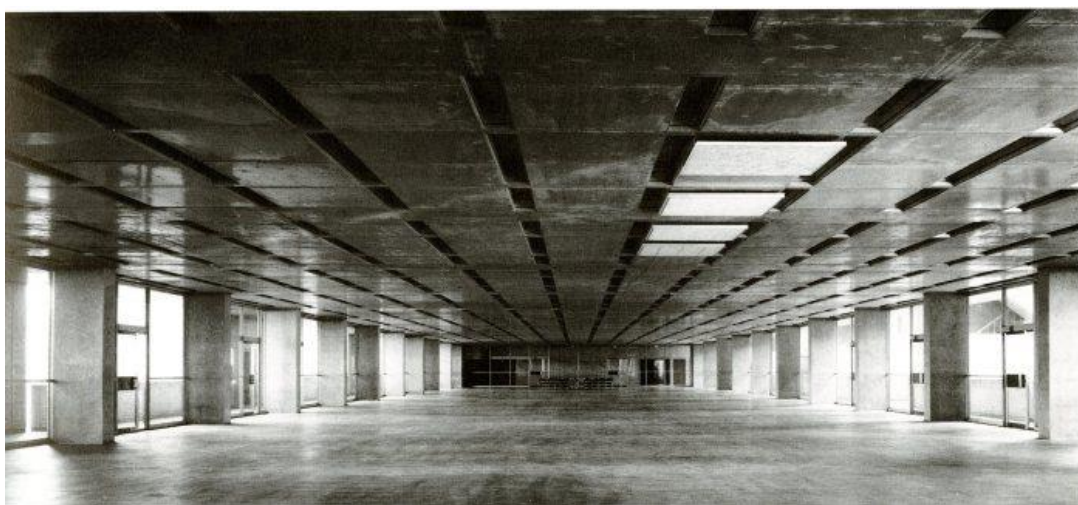
Figura 37 – Fotografia de um pavimento laboratorial, evidenciando seu espaço altamente flexível e as esperas de alumínio na laje. Fonte: STEELE (2002) p. 74
