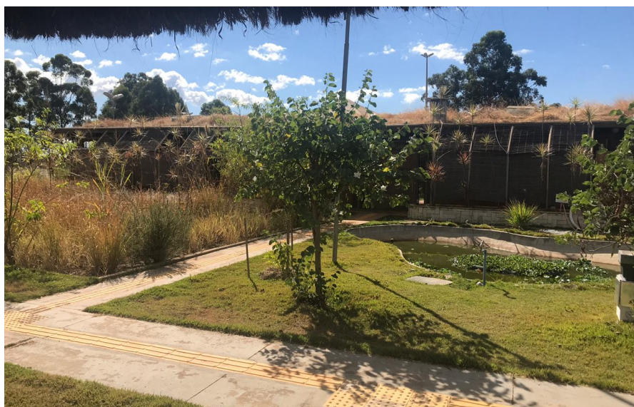
Figura 20 - Área de tratamento de esgoto por zona de raízes
