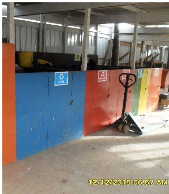
Figura 24 - Gestão de resíduos de obra
