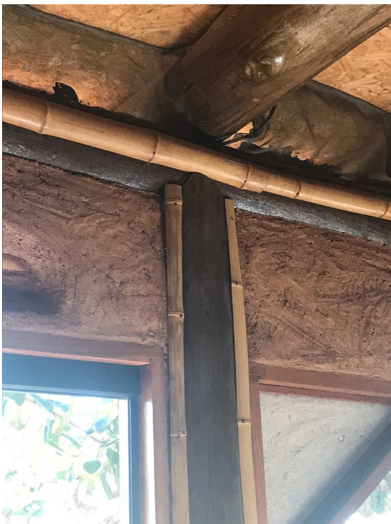
Figura 21 - Paredes em taipa de mão
