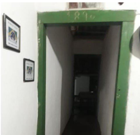
Figura 1- Batente da porta indicando o ano de construção. (Fonte: Própria)
