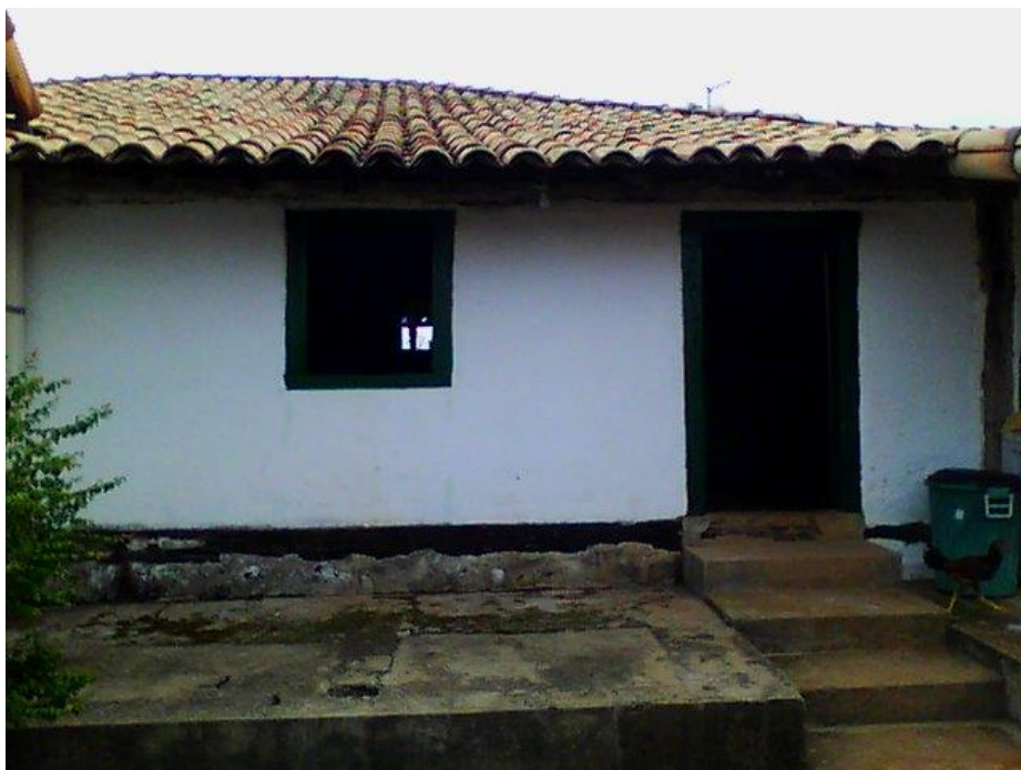
Figura 5- Parte externa da parede posterior. (Fonte: Própria)
