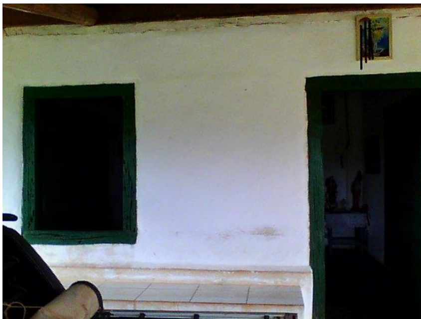
Figura 2- Fachada frontal encoberta por um beiral de mais de 5M. (Fonte: Própria)
