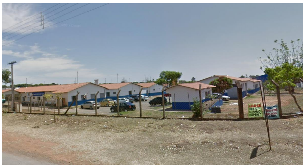
Figura 11: Fachada Lateral Direita do Hospital Regional do Jardim Ingá.
