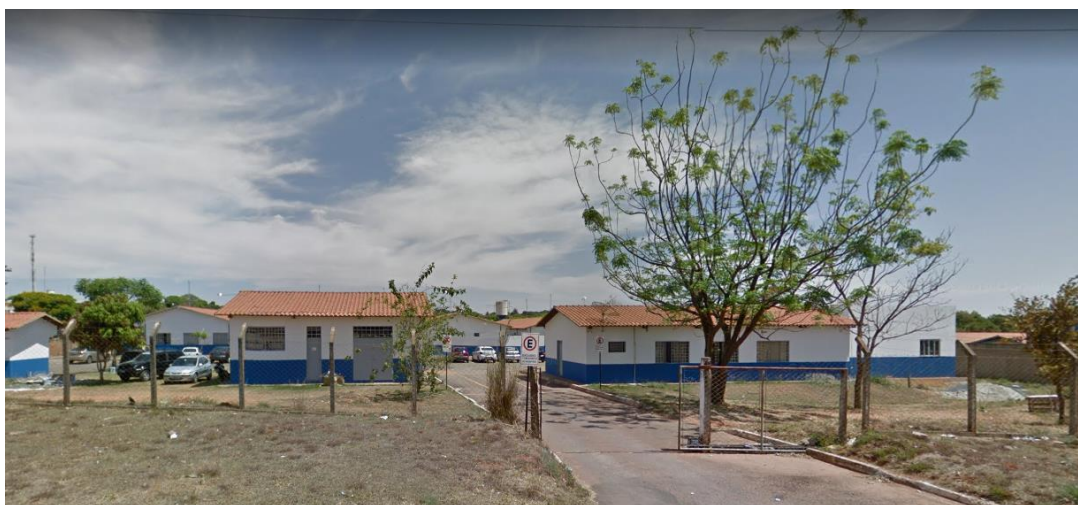
Figura 10: Fachada Lateral Direita do Hospital Regional do Jardim Ingá.
