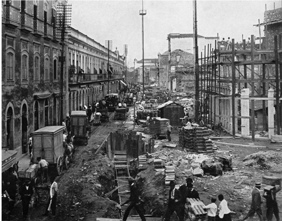
Figuras 20 e 21: Alargamento da Rua Carioca com a demolição dos cortiços, 1905.
