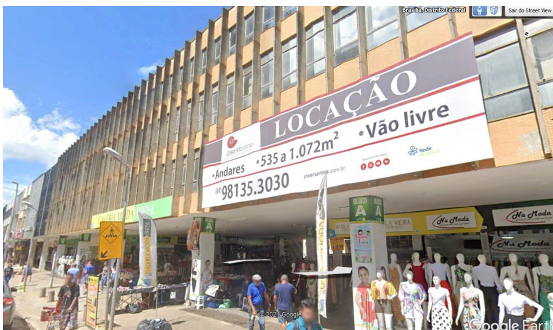
FIGURA 16: Edificação Tipo B - Setor Comercial Sul
