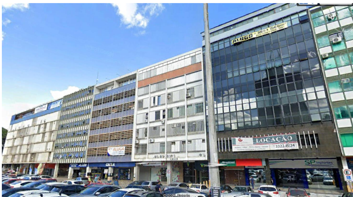
FIGURA 17: Fachada Norte – Edificação tipo C – Setor Comercial Sul
