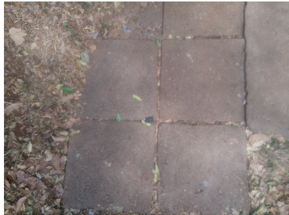
Figura 22 – placa de concreto
