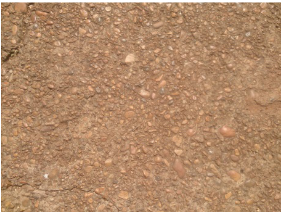
Figura 35 – piso de concreto
