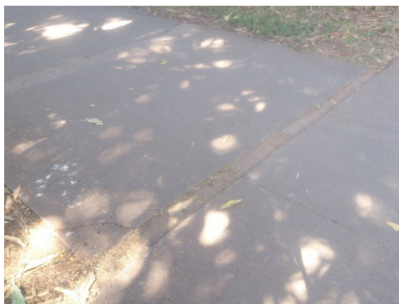
Figura 42 – piso de concreto
