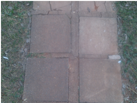
Figura 19 – placa de concreto
