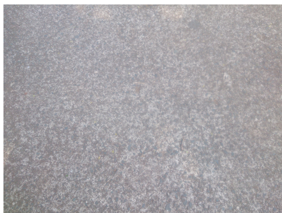
Figura 39 – piso de concreto
