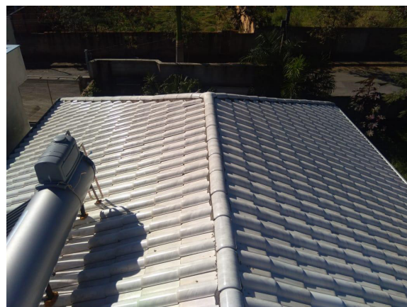
Figura 4 – Telhado superior da casa
